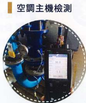
設備機房溫度檢測
